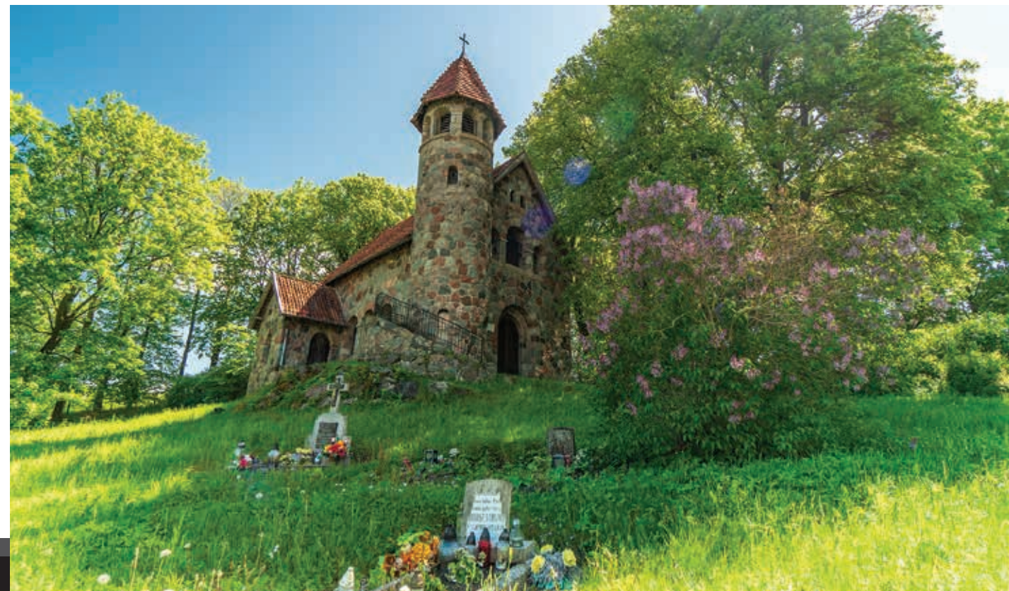
Kościół z kamieni polnych w Raszągu Fieldstone church in Rasząg
